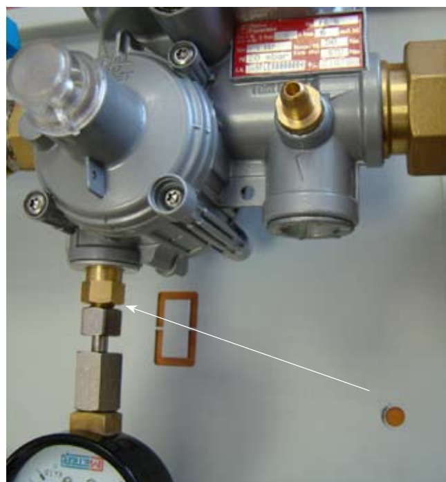
Рис.5. Штуцер типа Петерсон с подсоединенным манометром
