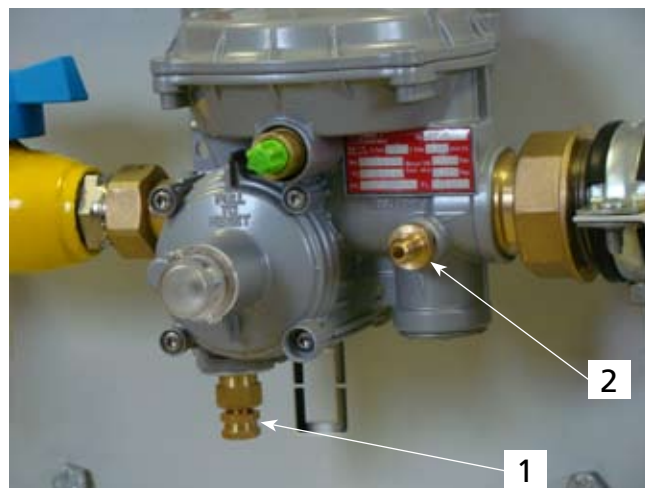
Рис.4 Штуцера отбора давления: 1 — «на входе» регулятора, типа Петерсон, 2 — «на выходе» регулятора.
