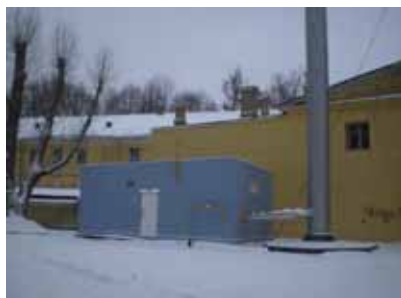
Котельная (Каменноостровский пр., 81): до и после реконструкции
