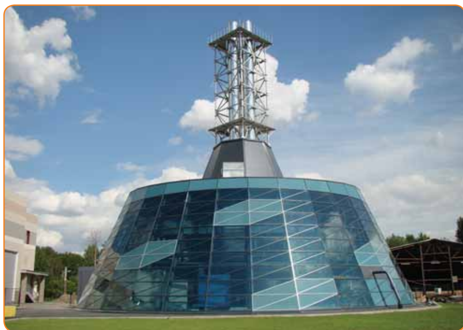
Котельная для стадиона «Санкт-Петербург Арена» мощностью 56 МВт
