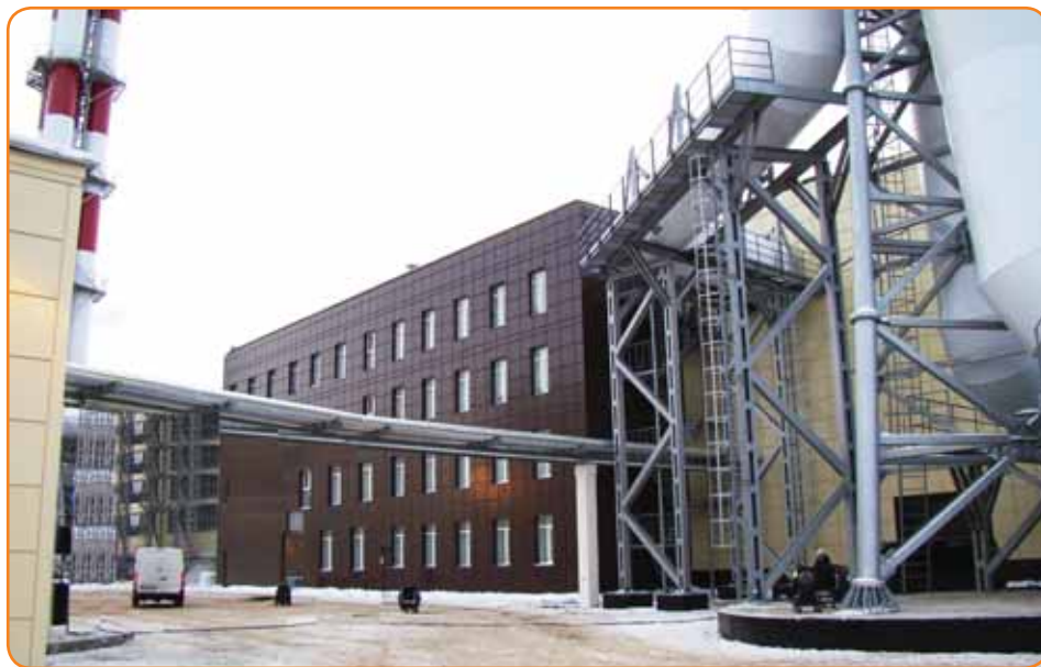
Котельная в г. Ломоносове (Санкт-Петербург, Петродворцовый район) мощностью 415 МВт
