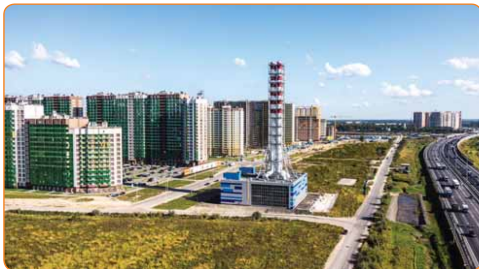
Котельная для нового жилого микрорайона в пос. Мурино (Ленинградская обл., Всеволожский район) мощностью 240 МВт
