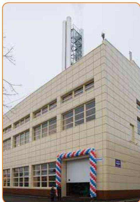
Котельная на ул. Красного Курсанта, 20 (Санкт-Петербург) мощностью 58,8 МВт
